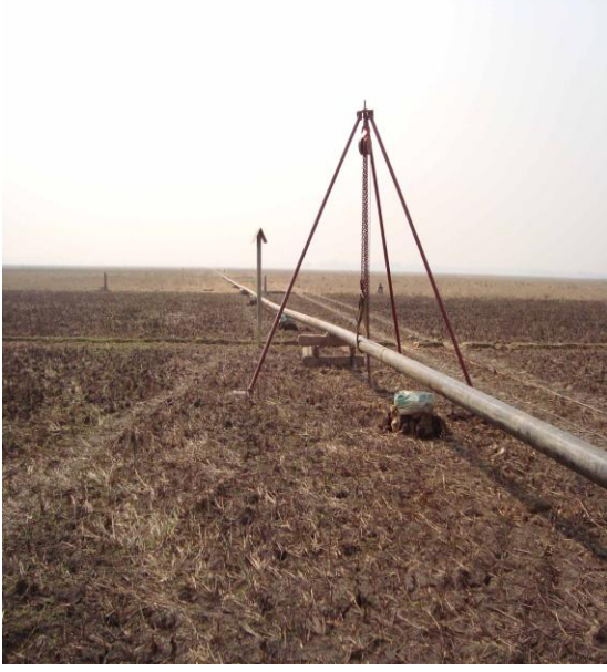
চিত্র ১: বিবিয়ানা গ্যাস ফিল্ড হতে আউশকান্দি পর্যন্ত গ্যাস সঞ্চালন পাইপলাইন নির্মাণ কার্যক্রম
