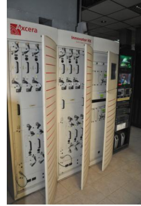
চিত্র ৪: Digital Terrestrial Transmitter
