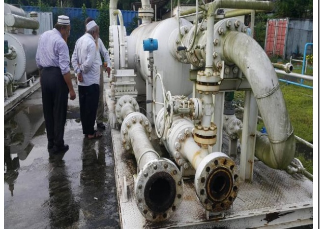
চিত্রঃ বর্তমানে অব্যবহৃত একটি 60 mmscfদ skid mounted test separator (সালদা গ্যাস ক্ষেত্র)
