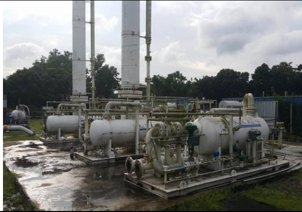
চিত্রঃ বর্তমানে অব্যবহৃত দুটি (Process Plant) 30 mmscfদ skid mounted TEG plant এবং একটি 60 mmscfদ skid mounted test separator (for Salda)
