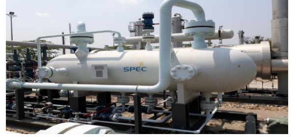
চিত্র-২: ভোলার শাহবাজপুর গ্যাস ক্ষেত্রে প্রকল্পের আওতায় স্থাপিত গ্যাস প্রসেস প্ল্যান্টের স্থি ফেজ সেপারেটর।
