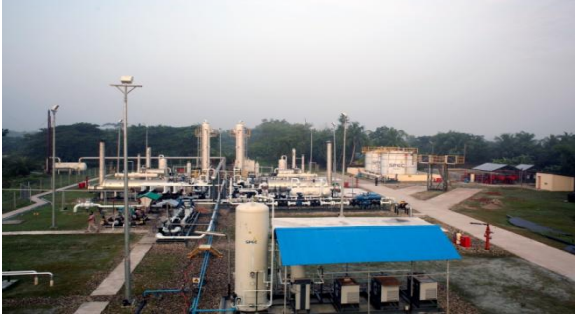
চিত্র-১: ভোলার শাহবাজপুর গ্যাস ক্ষেত্রে প্রকল্পের আওতায় স্থাপিত গ্যাস প্রসেস প্ল্যান্ট।
