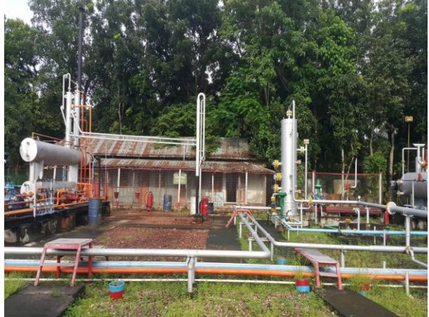
চিত্রঃ বর্তমানে সালদা গ্যাস ক্ষেত্রে ব্যবহৃত পুরাতন Process Plant যার মাধ্যমে কূপ হতে উৎপাদিত গ্যাসসমূহ ব্যবহারযোগ্য করা হয়
