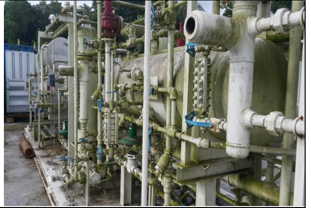
চিত্রঃ 30 mmscfদ skid mounted TEG plant এর যন্ত্রাংশের উপর শ্যাওলা (সালদা গ্যাস ক্ষেত্র)
