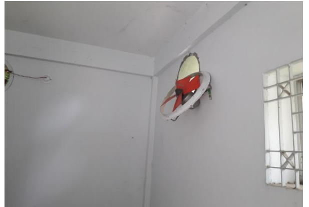
ছবিচিত্র ৬: জেনারেটর রুমে স্থাপিত Exhaust Fan
