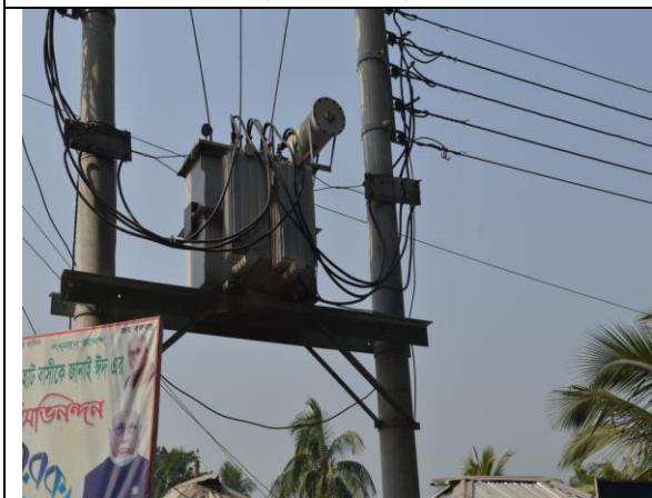
চিত্র-৫- প্রতিস্থাপিত নতুন পোল মাউন্টেড বিতরণ ট্রান্সফর্মার (বাগেরহাট জেলা)
