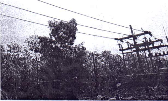
চিত্র-১: গজারিয়াপাড়া সাবস্টেশন থেকে নির্মিত বিতরণ লাইন
